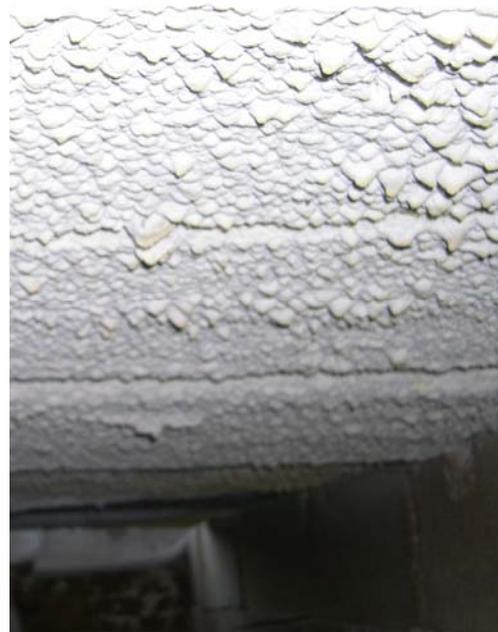
Questa certificazione ha stabilito per la prima volta un'equivalenza diretta tra un dato spessore di pittura intumescente e lo spessore di calcestruzzo che è in grado di dare lo stesso isolamento termico. In questo modo è facile calcolare quanta pittura intumescente è necessario applicare per integrare un copriferro insufficiente.
